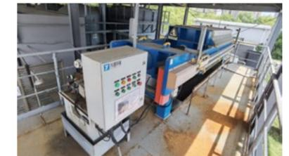
冰箱压缩机废水站新设备——板框压滤机
