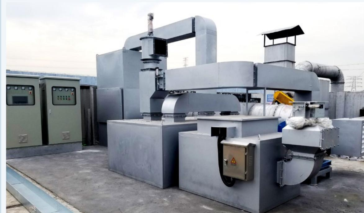
有机废气减排改造装置
