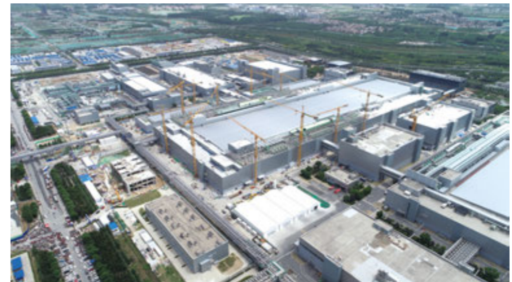
三星(中国)半导体二期项目建设现场
