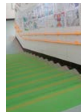
安装防滑条、无障碍一字扶手
