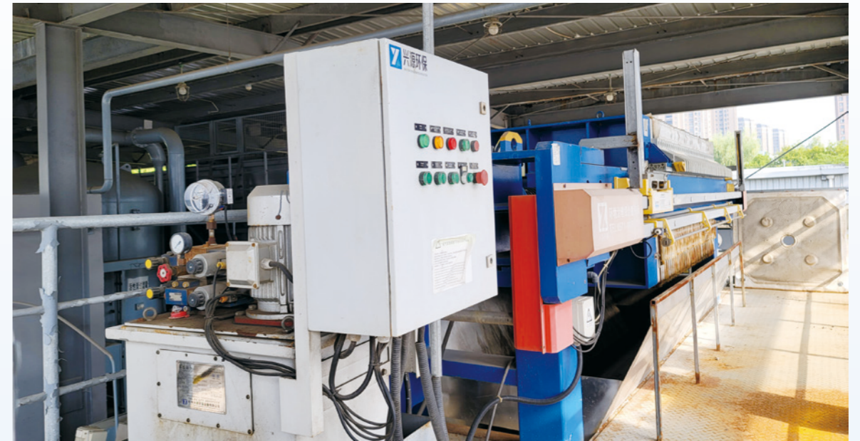
污泥减量化设施改造
